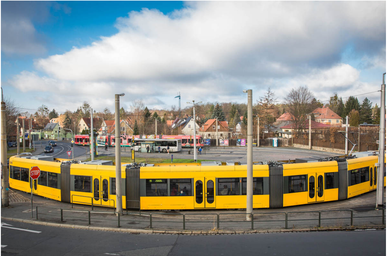
Marode und schwer zu überqueren: der Ullersdorfer Platz in Bühlau. © Sven Ellger
