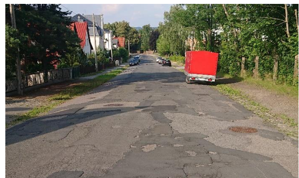
Im Bergabschnitt muss die Fahrbahn dringend saniert werden. Ein Parkverbot talwärts würde niemandem wehtun, aber Dooring verhindern.
