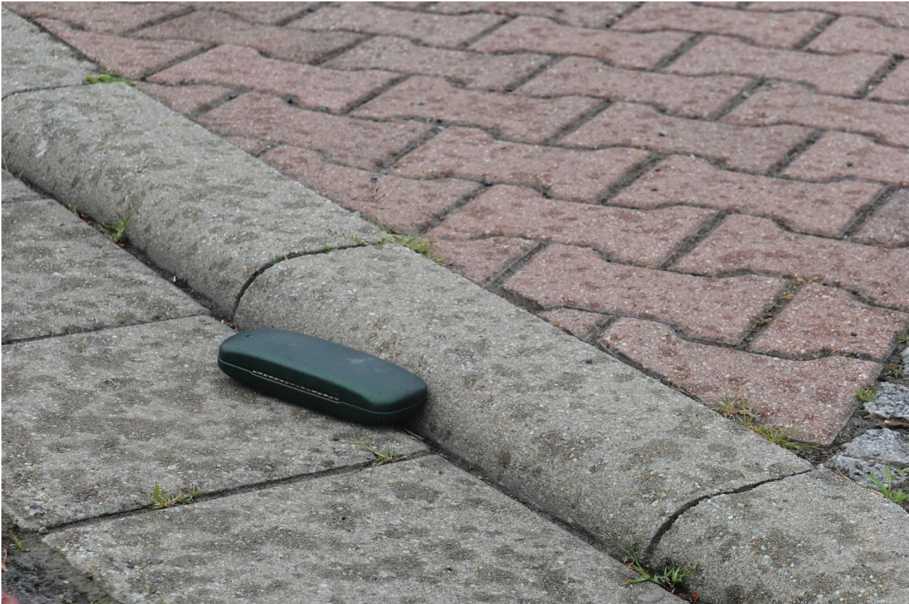
Durch das angelegte Brillenetui wird verdeutlicht, dass der Bordstein mit ca. 6-8 cm zu hoch ist, um zügige Fahrt zu ermöglichen
