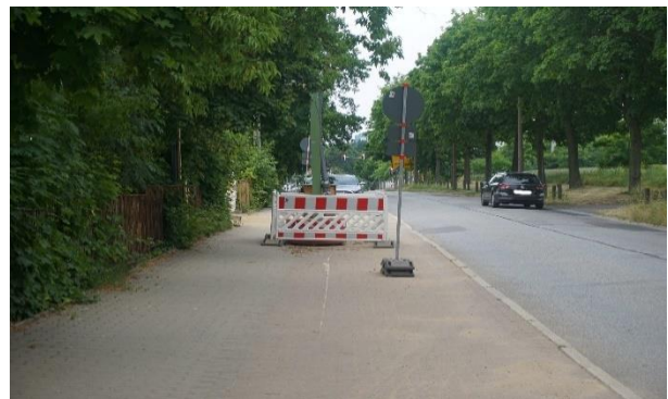
Sicht in Richtung Bergstraße mit baustellenbedingt gesperrtem Parkstreifen (Ex-Radweg) auf der Nordseite (links im Bild). Der freigegebene Fußweg auf der rechten Bildseite mündet direkt auf der Fahrbahn.
