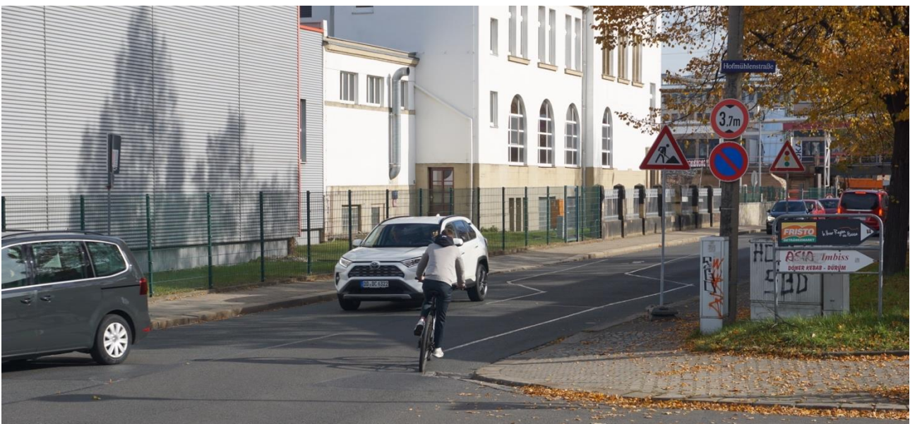
Die Umfahrung des Gullideckels an der Hofmühlenstraße birgt Gefahren.
