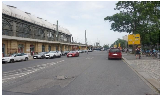
Bayrische Straße: überbreit, unklar organisiert, teilweise schlechter Oberflächenbelag.
