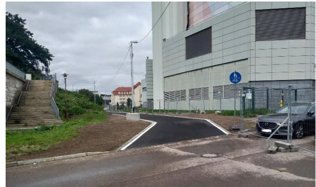
Der neue Durchstich am Heizkraftwerk als temporäre Umleitung zur Oederaner Straße
