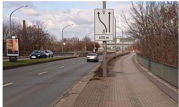
Von der Budapester Straße kommend würde man ungefähr an dieser Stelle erst auf den breiten, geschützten Hochbordradweg geführt.
