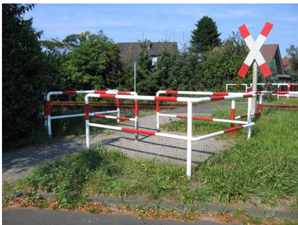
Umlaufsperr/Umlaufgitter an Bahnübergang.
