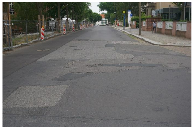
Miserable Fahrbahnbeschaffenheit auf der Mommsenstraße
