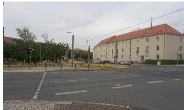
Einmündung in die Münchner Straße, aus Sicht Nöthnitzer Straße
