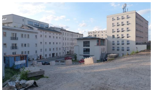
Blick von der Gleisbaustelle über die Baurampe in den Innenhof der Bienertmühle – für den Radverkehr wäre natürlich eine filigranere Konstruktion sinnvoll.
