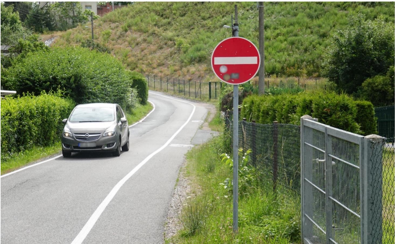
Die Mitnutzung des Gehwegstreifens durch Radfahrer*innen ist möglich, da an dieser Stelle nahezu keine Fußgänger*innen unterwegs sind
