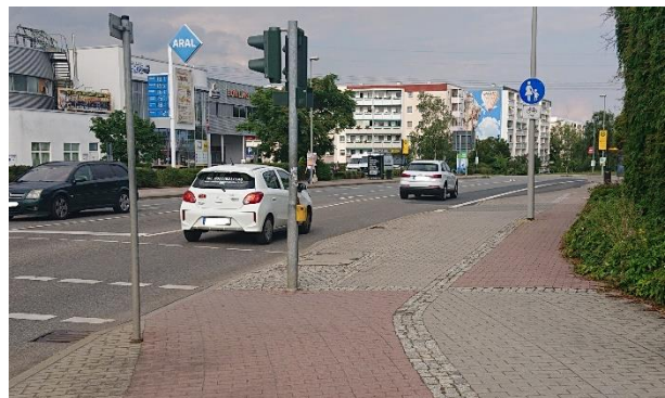
Trotz der Rotpflasterung werden Radler*innen, die schneller als Schrittgeschwindigkeit fahren wollen, auf die Kfz-Fahrbahn verwiesen. Eine sichere Einmündung in die Fahrbahn gibt es nicht.
