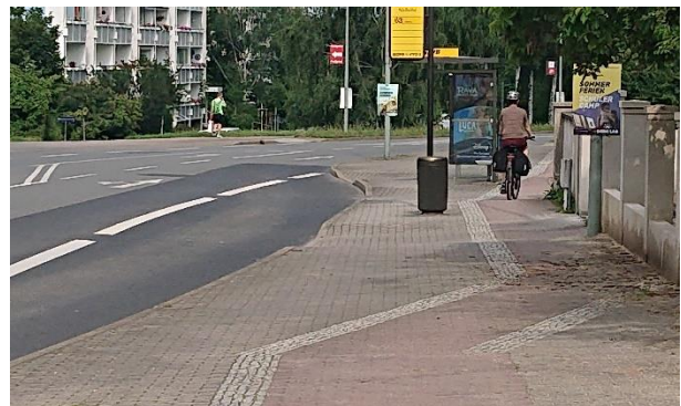
An der Haltestelle Südhöhe wurde der alte Radweg hinter die Haltestelle und damit direkt an die Einfahrten gequetscht. Ohne die nicht mehr zeitgemäßen Busbuchten gäbe es jedoch gar kein Platzproblem! Busse können heute auch auf der Fahrbahn halten.
